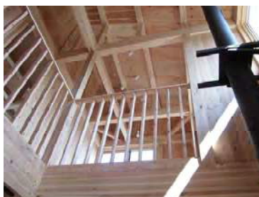
新たな木造建築工法の住宅 （ロケット工法）
