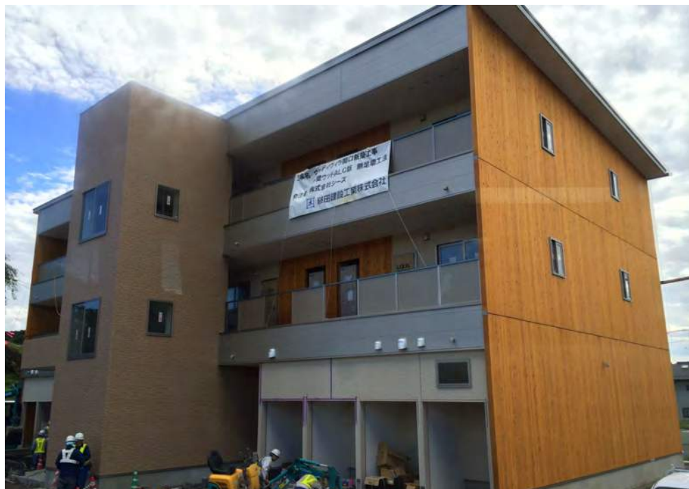
国産スギ集成材の防耐火パネル「WOOD.ALC」を用いた共同住宅
