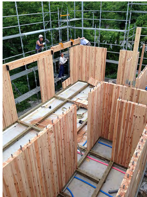
「森の貯金箱」柱角材連結パネル壁の FSB 工法 (株式会社結(ゆい)設計ホームページより)
