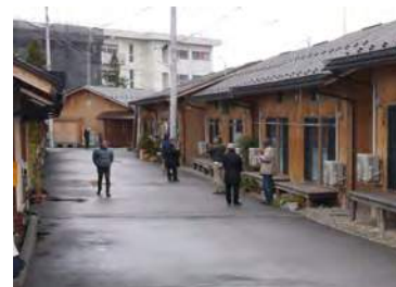
木造災害公営住宅現場研修（福島）
